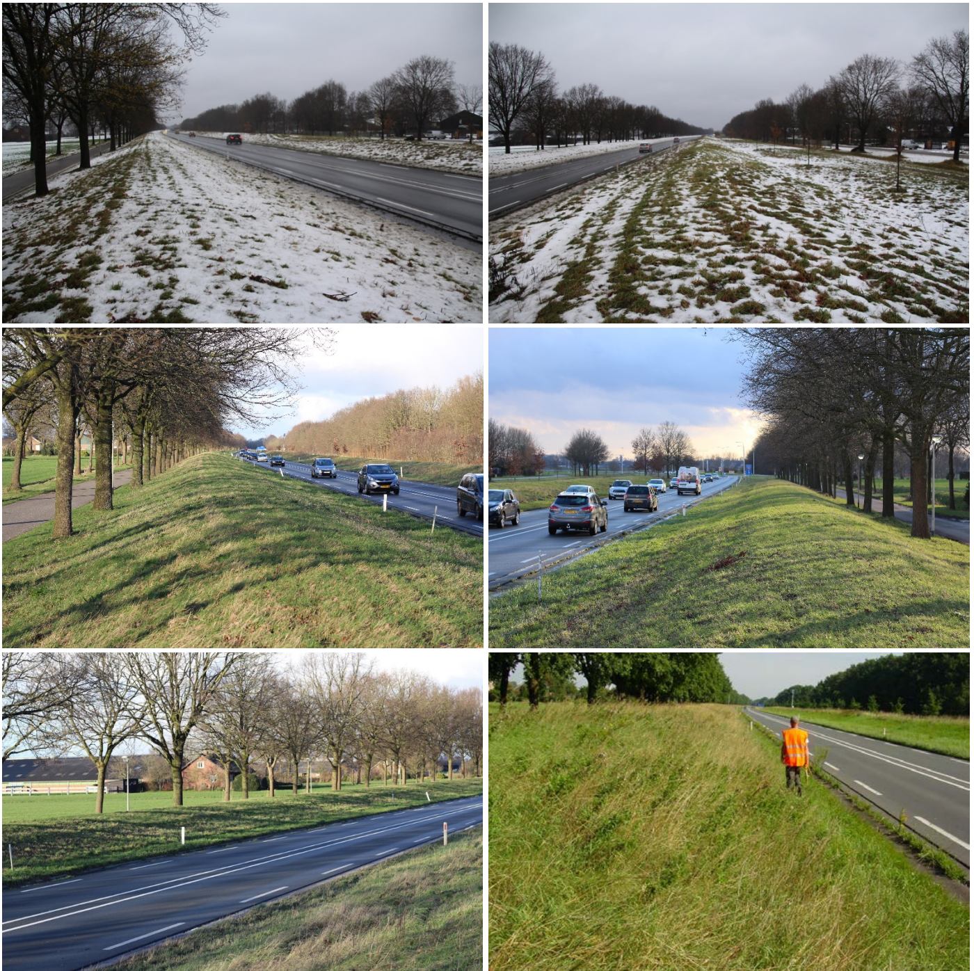
Figuur 5. Op de foto links boven komen de auto's vanuit het noorden vanaf Roosendaal en laat de berm aan de westzijde van de N262 zien. Foto's boven en linksonder betreft de situatie van de berm op 19 januari 2018. Foto rechts onder betreft dezelfde locatie, maar dan op 14 augustus 2017. Foto: Wim Dimmers©. Op die foto is te zien dat de berm sterk is vergrast en er weinig bloeiende kruiden staan waar bloembezoekende insecten, zoals wilde bijen, hun voedsel kunnen vinden.
